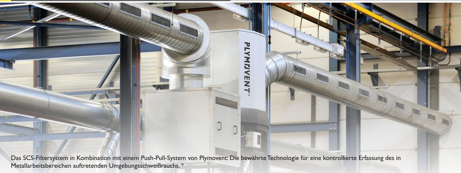
Das SCS-Filtersystem in Kombination mit einem Push-Pull-System von Plymovent: Die bewährte Technologie für eine kontrollierte Erfassung des in Metallarbeitsbereichen auftretenden Umgebungsschweißrauchs.\*
