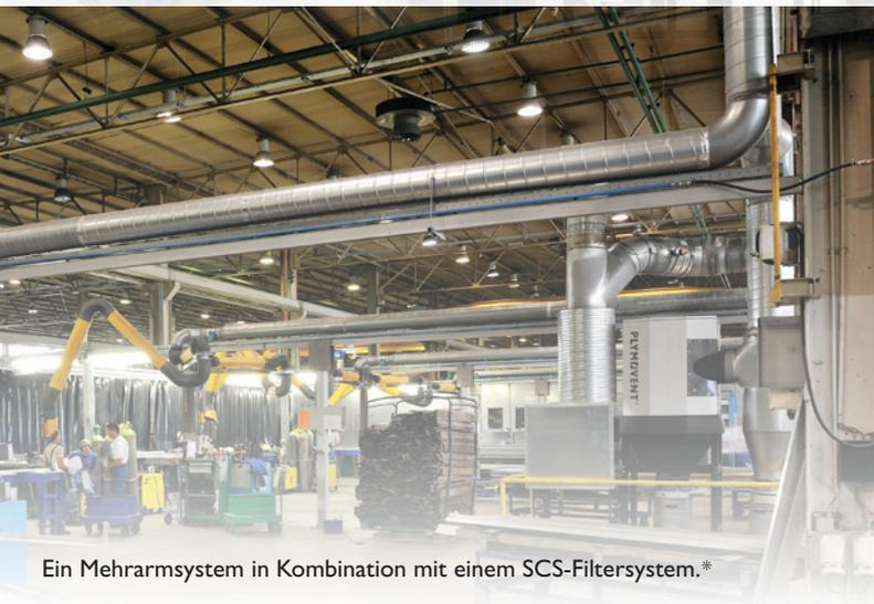
Ein Mehrarmsystem in Kombination mit einem SCS-Filtersystem.\*
