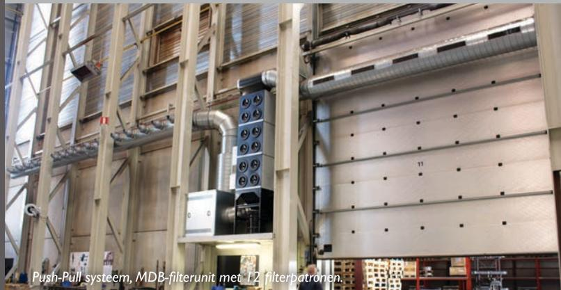
Push-Pull systeem, MDB-filterunit met 12 filterpatronen.
