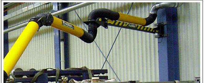
Der FlexMax eignet sich für Arbeitsbereiche mit niedriger Deckenhöhe (Befestigungshöhe mind. 2 m)
