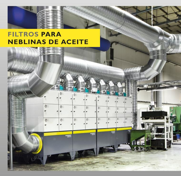
Sistema de filtración para una eliminación efectiva de las neblinas de aceite
