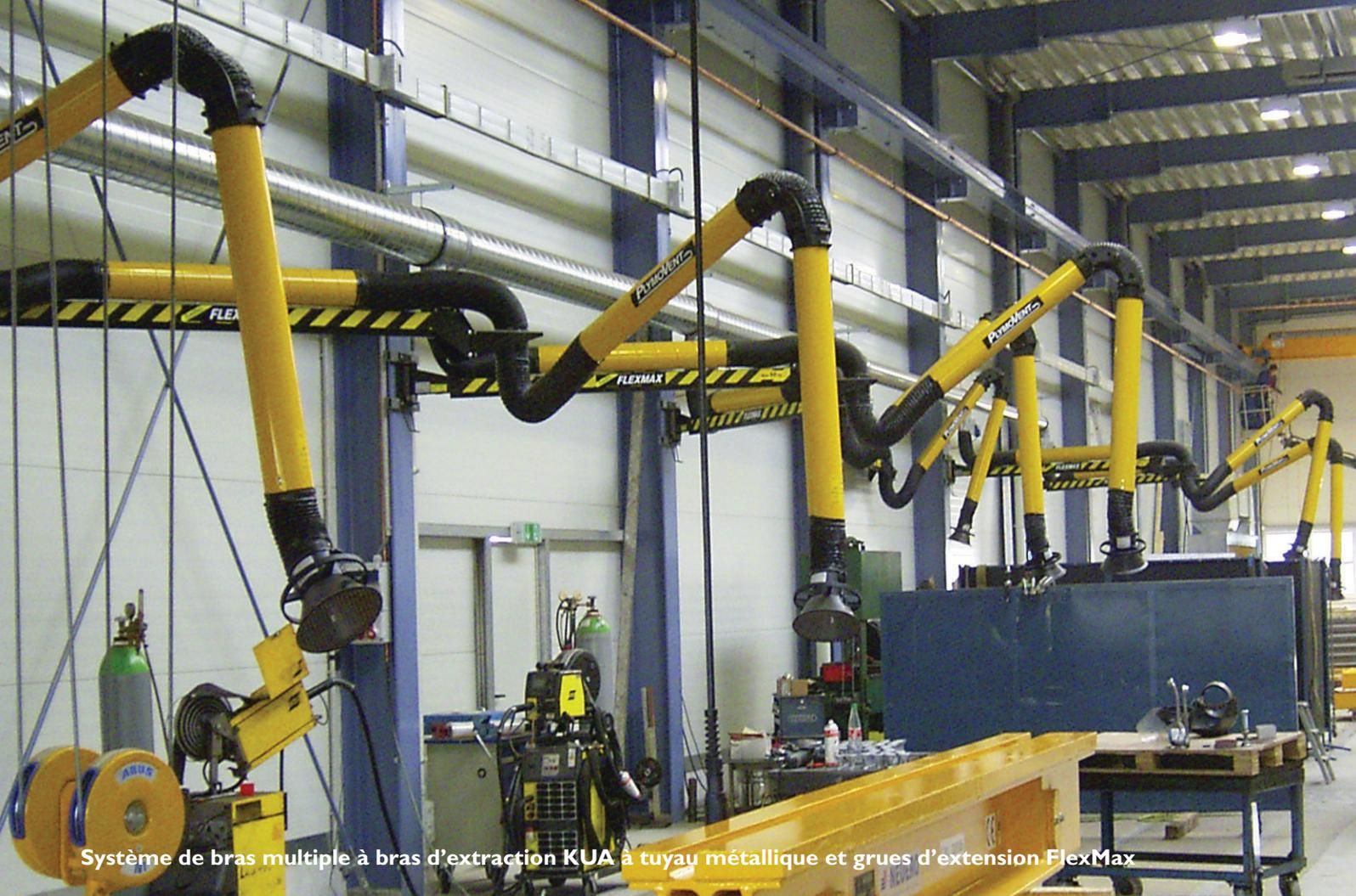
Système de bras multiple à bras d'extraction KUA à tuyau métallique et grues d'extension FlexMax
