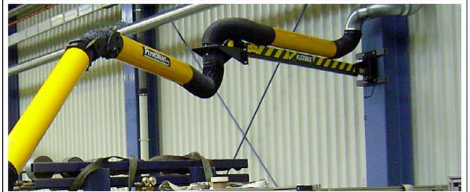
Le FlexMax peut être installé dans des zones à plafond bas (hauteur de montage min. 2 m)
